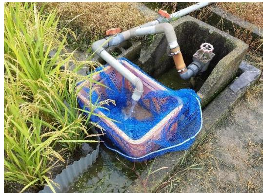
取水口に設置した侵入防止資材の例
